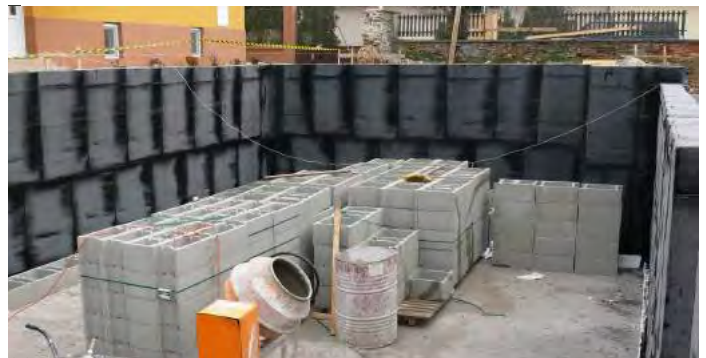
Apartmanház pinceszigetelése, Sárvár
