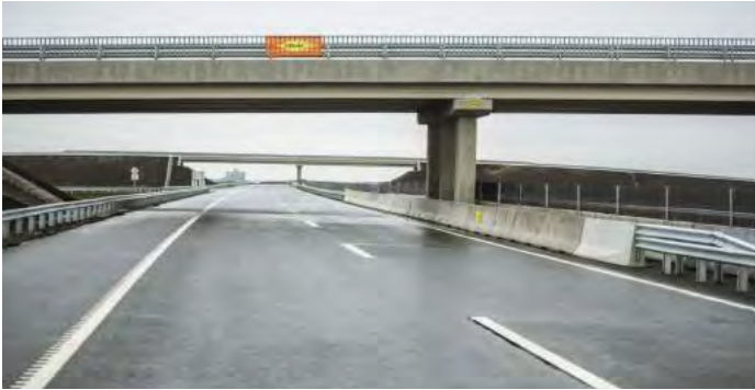
M86 hídszigetelés HÍD-2 rendszerrel
