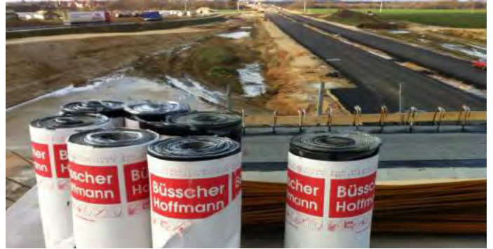
M35 hídszigetelés HÍD-2 rendszerrel
